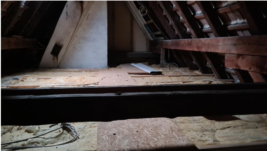
Abbildung 35: Dämmung oberste Geschossdecke – Grundschule
